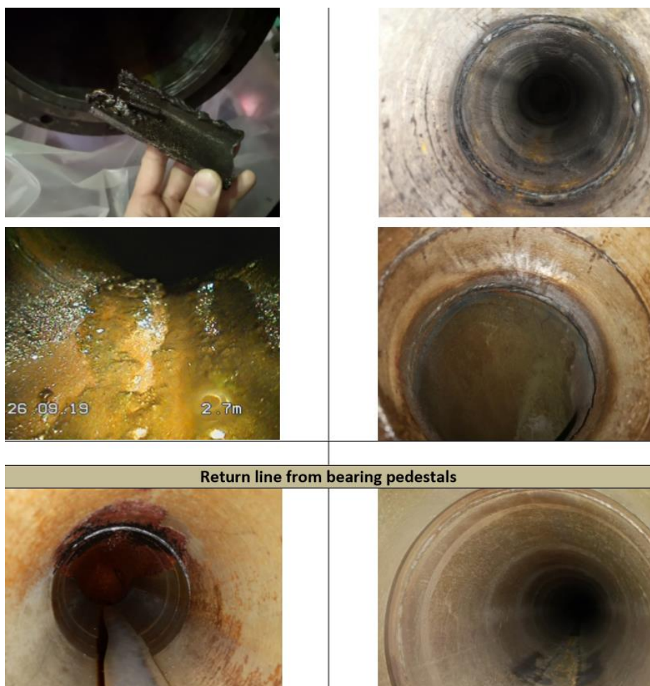
Фото 5.22. Зовнішній вигляд внутрішньої поверхні трубопроводів до і після гідродинамічного очищення
