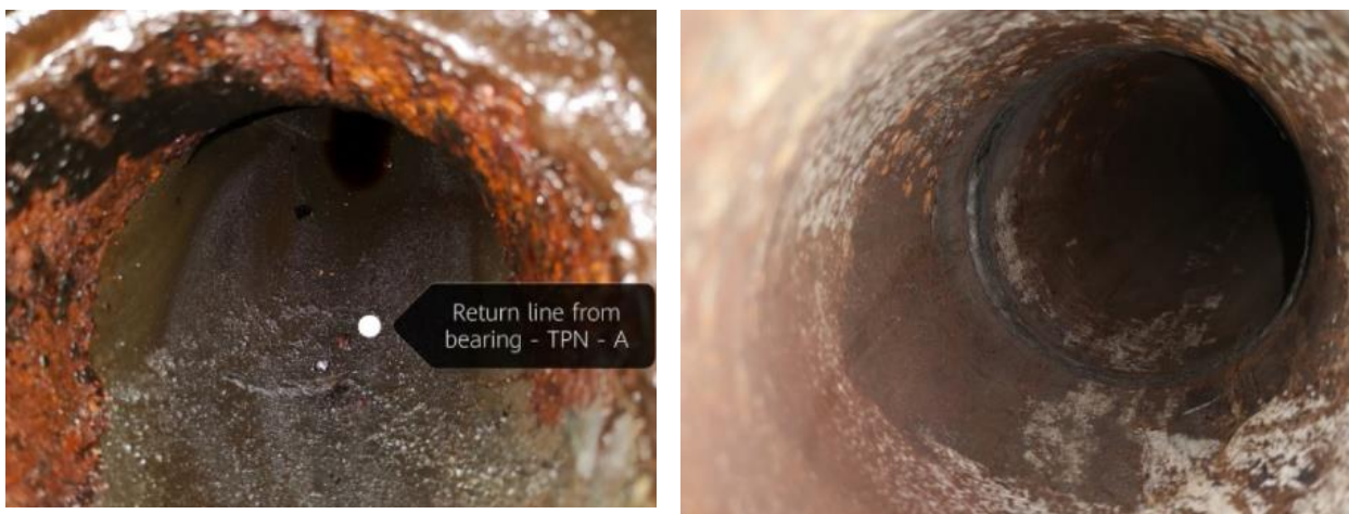
Фото 5.18. Лінія повернення оливи з підшипників (до і після гідроочищення)
