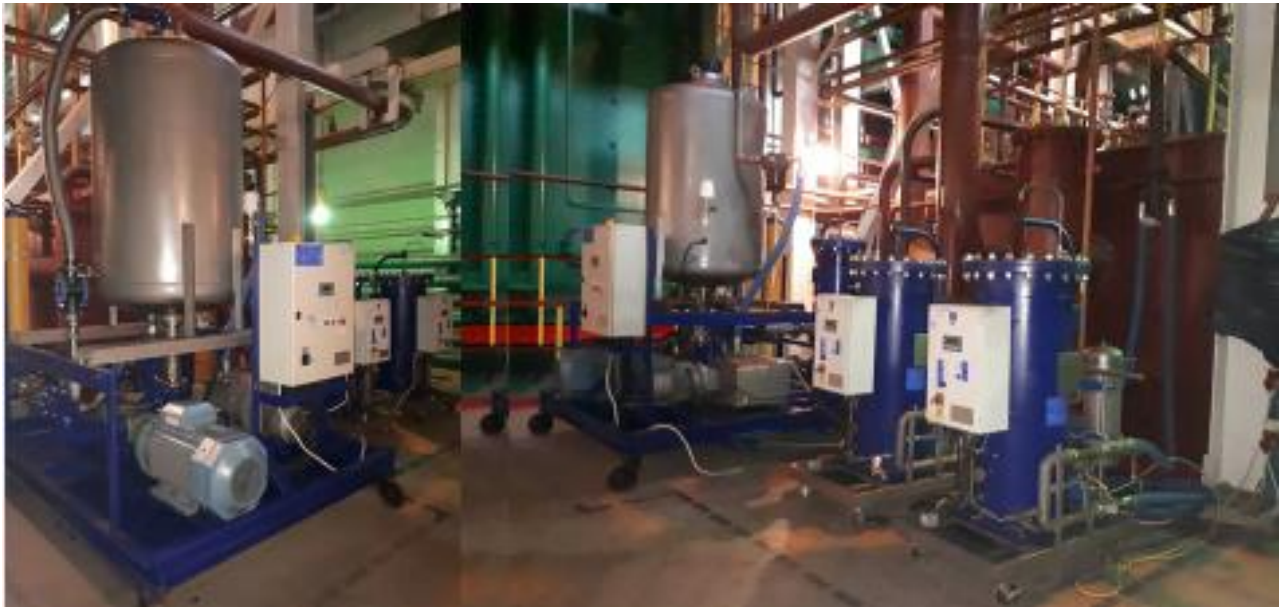
Фото 5.3 – Установка PALL HNP-200 разом з іонообмінними модулями в роботі.
